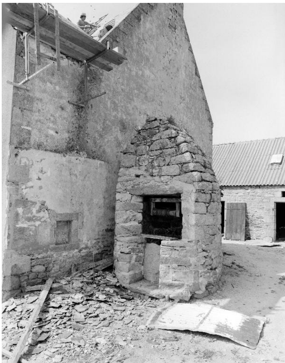
Praterou, Ferme : puits à l'est, vue générale sud
