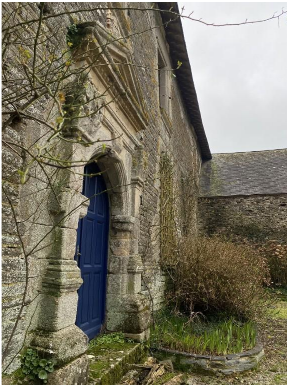
Porte, élévation ouest, détail
