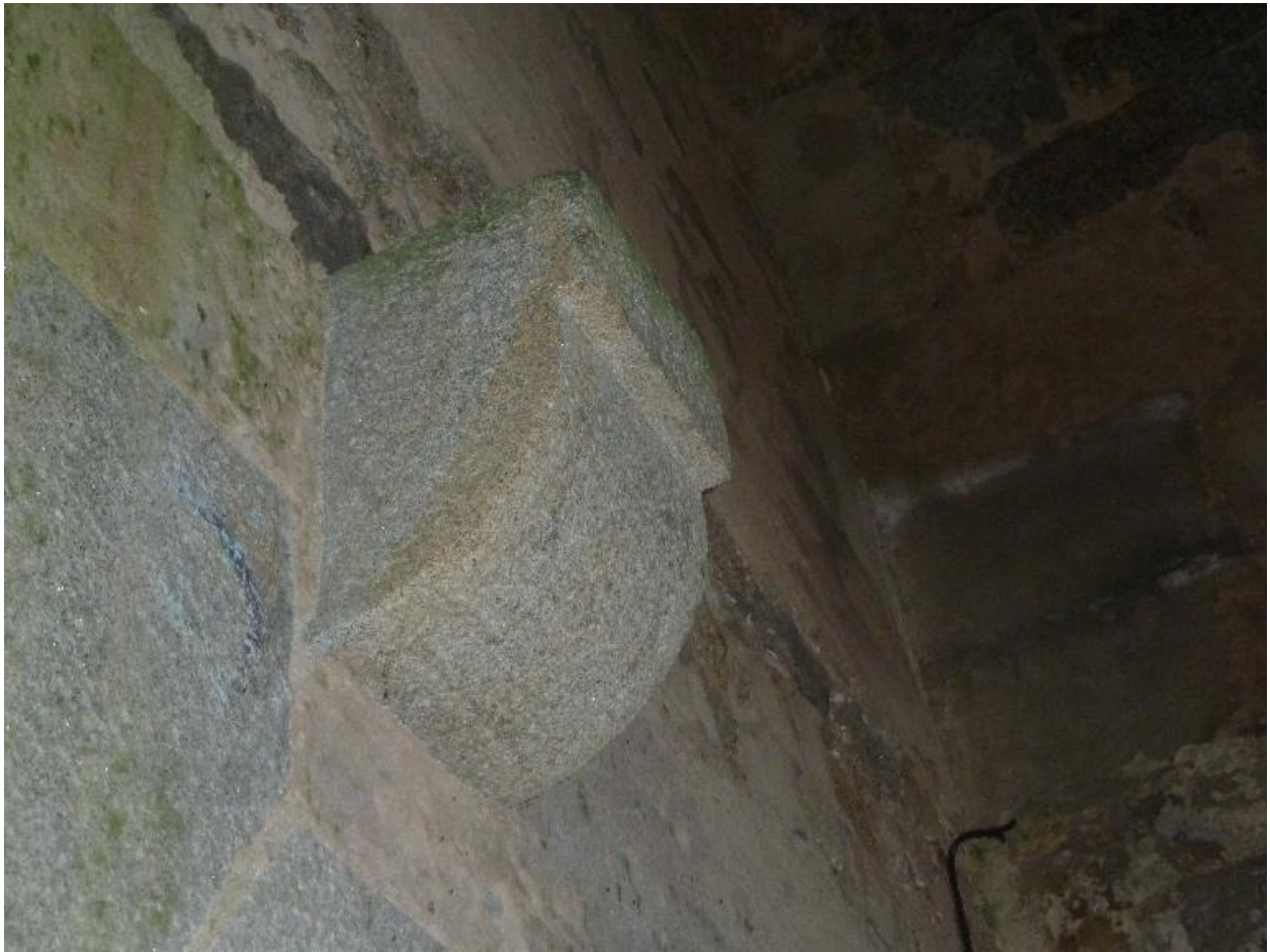
Hoedic, fort central, magasin à poudre, chambre de stockage, détail d'un corbeau du plancher de l'étage.
