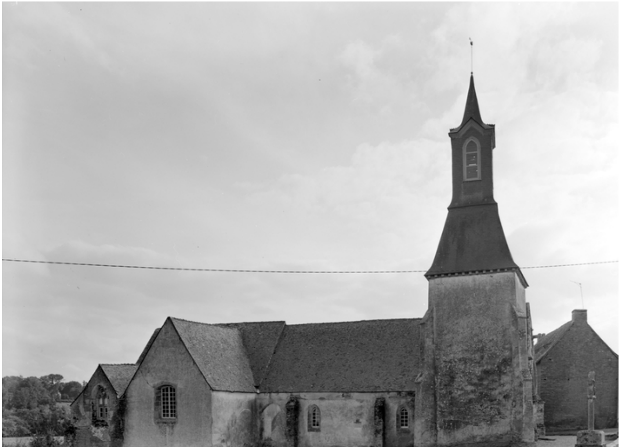
Chapelle Saint-Golven : élévation nord (état en 1984)
