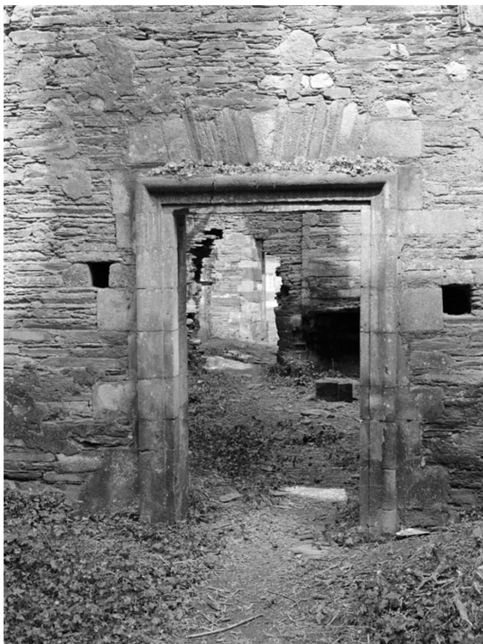
Logis abbatial : porte nord du vestibule ouvrant sur l'ancien salon (état en 1977).
