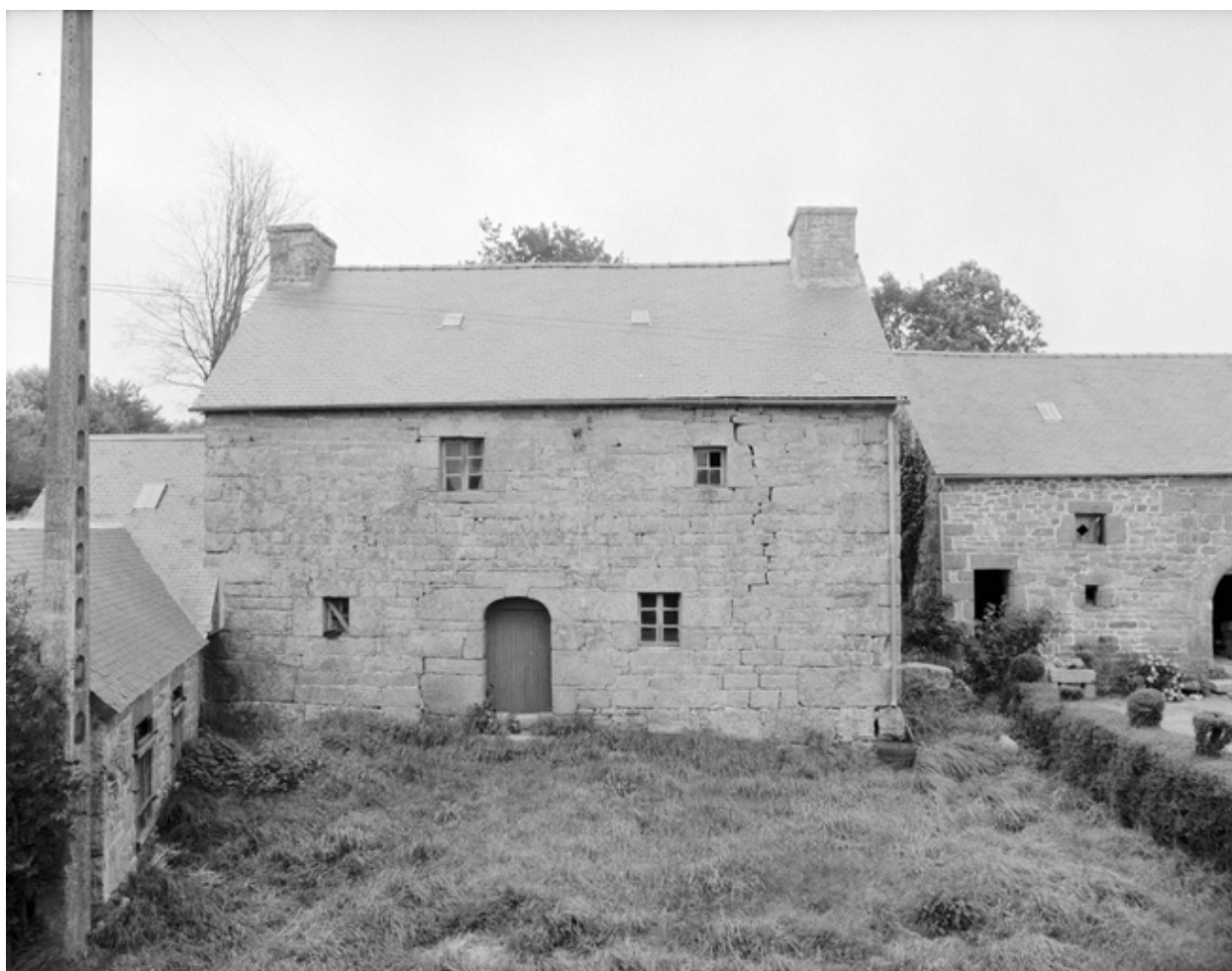
Kerjulou, maison, bâtiment principal A, vue de la façade est
