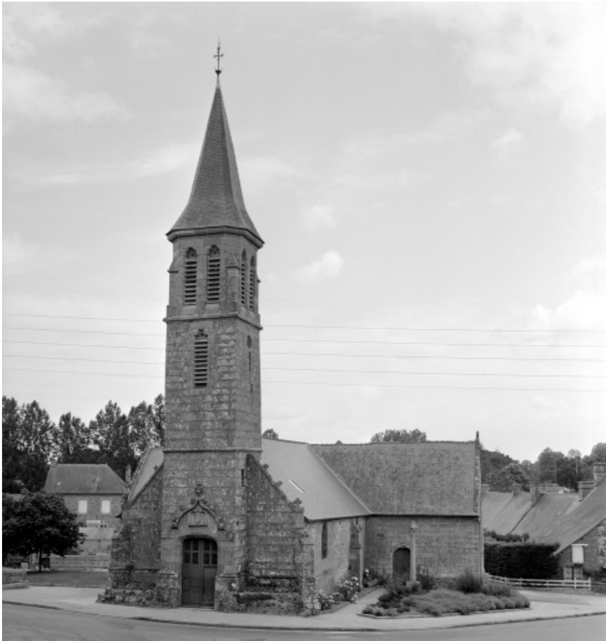
Elévation Ouest : vue générale
