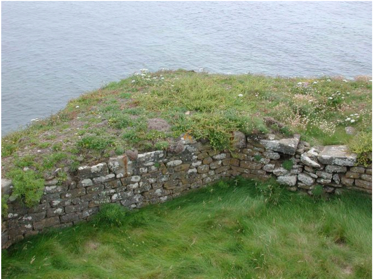
Vue de détail du parapet (état en 2006)
