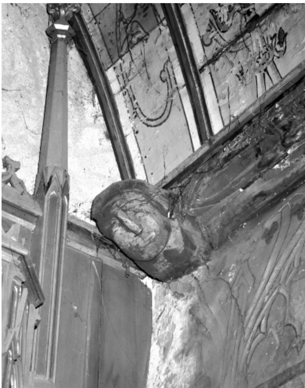
Intérieur, sablières : détail d'un blochet.
