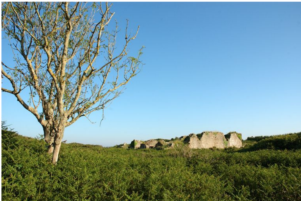
Vue générale du fort Cézon : casernes ruinées
