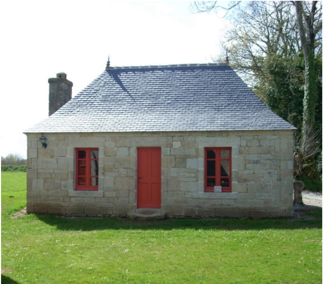
Chapelle de Plas-Caër et Notre-Dame : sacristie : vue générale est
