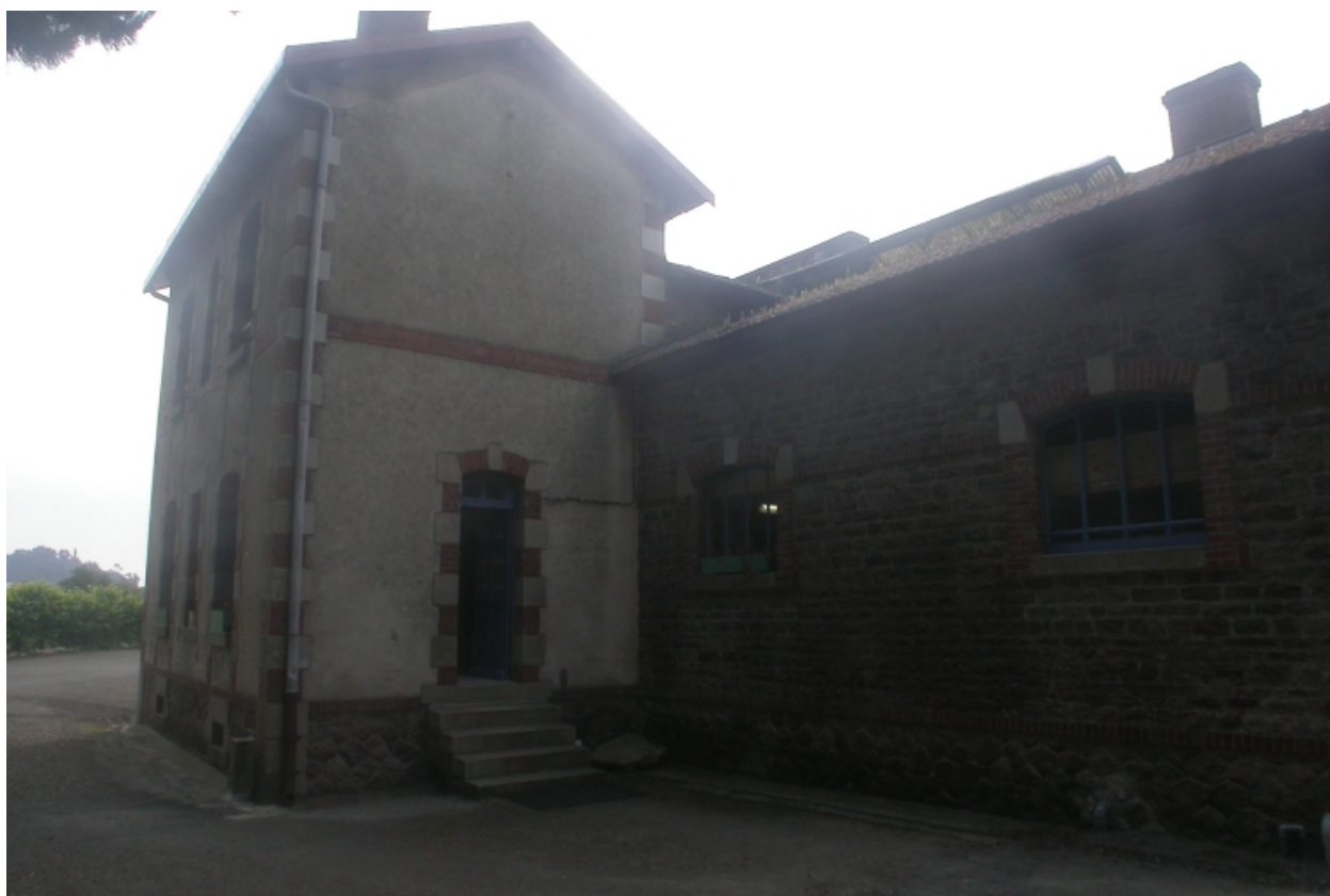
Façade postérieure au nord
