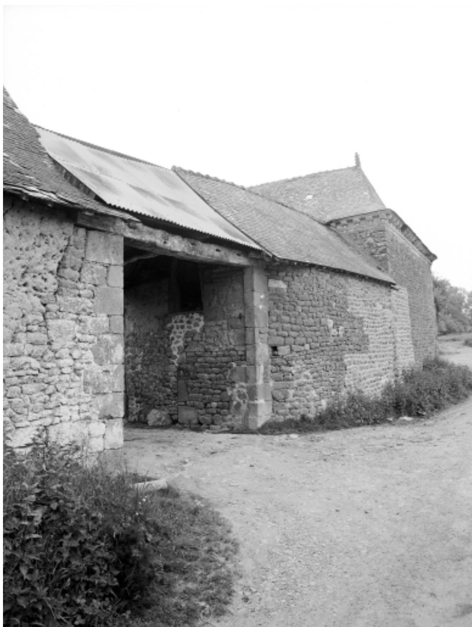
Porche, vue générale de l'extérieur.
