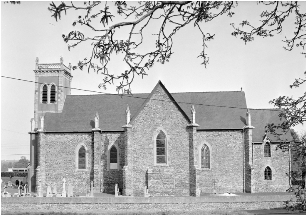
Elévation Sud : vue générale
