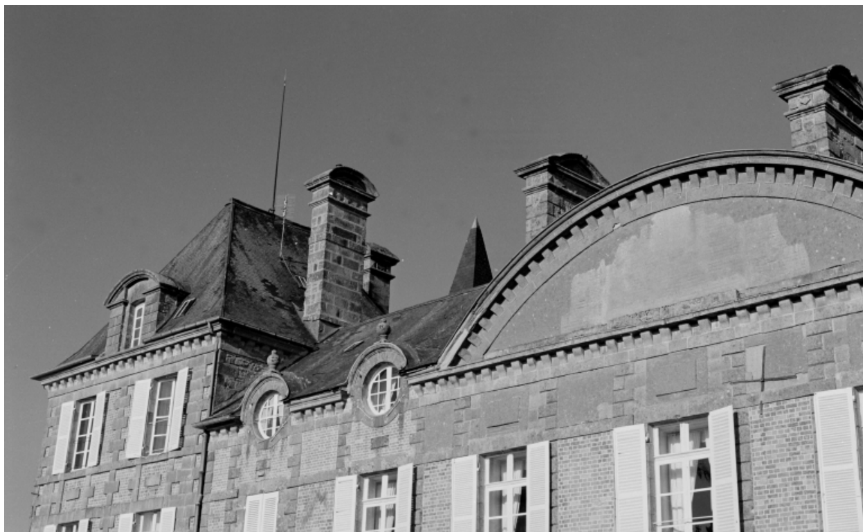
Détail de la façade postérieure
