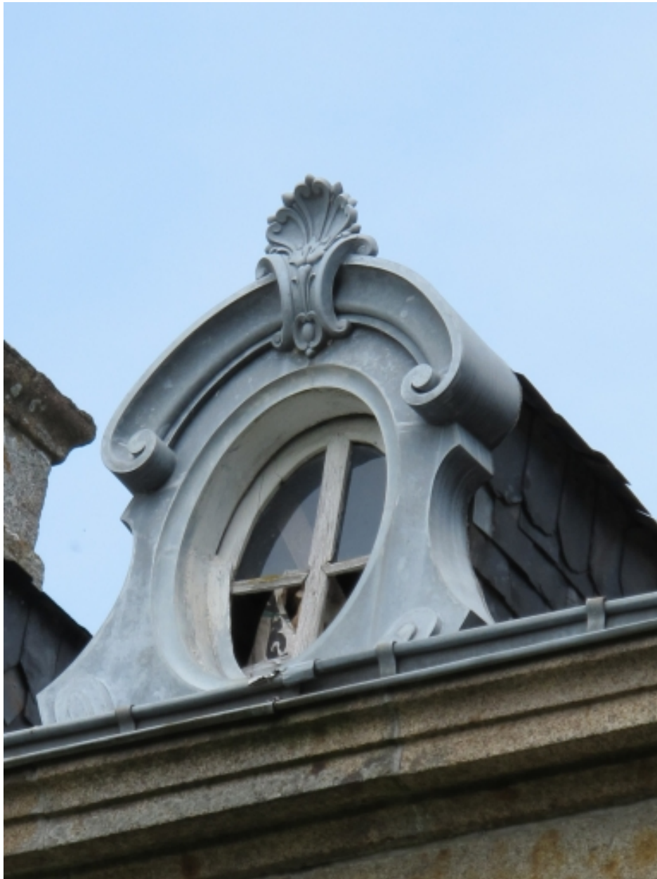
Ouverture en zinc dans le toit
