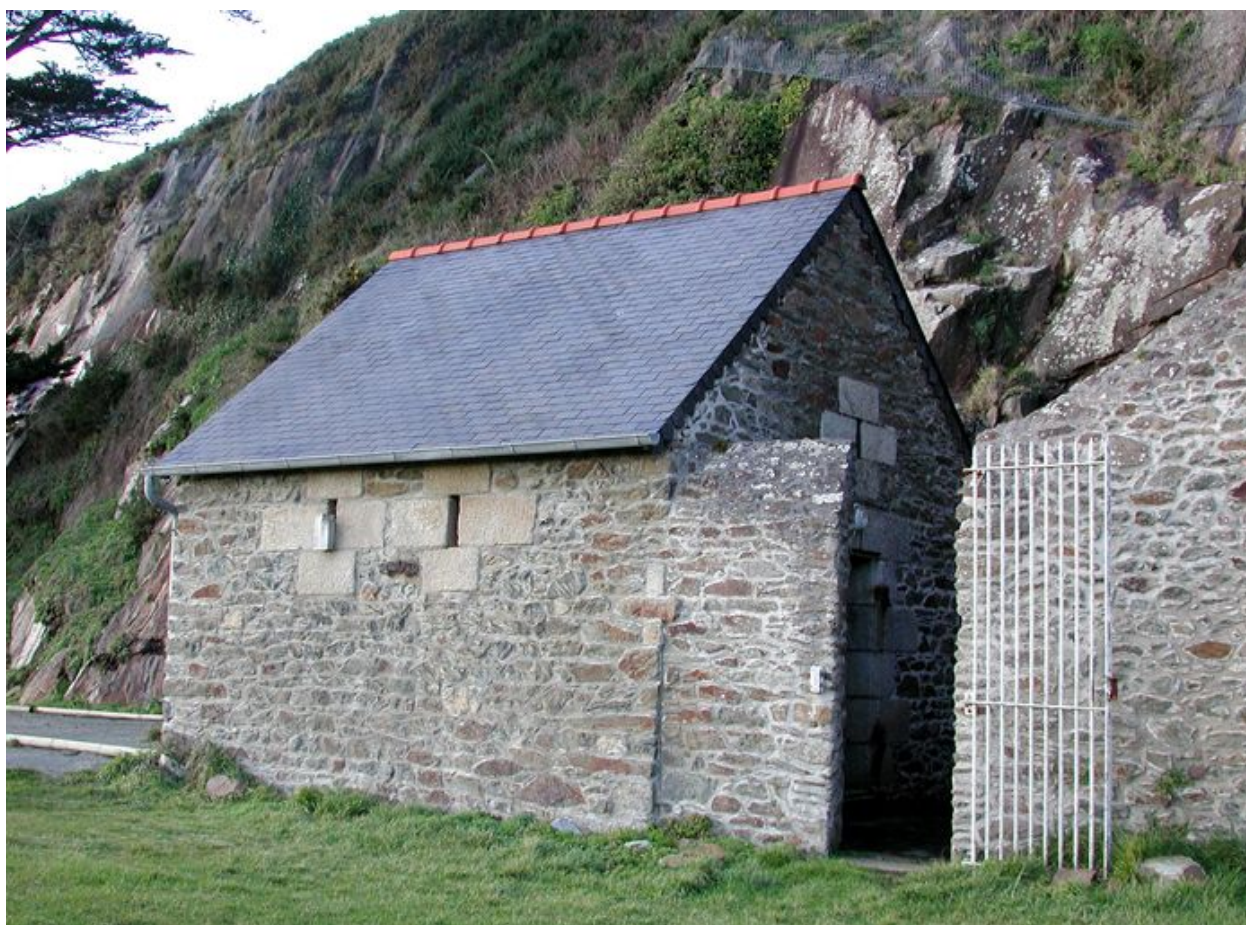
Vue du fort du Mengant : magasin à poudre reconnaissable à ses événements d'aération
