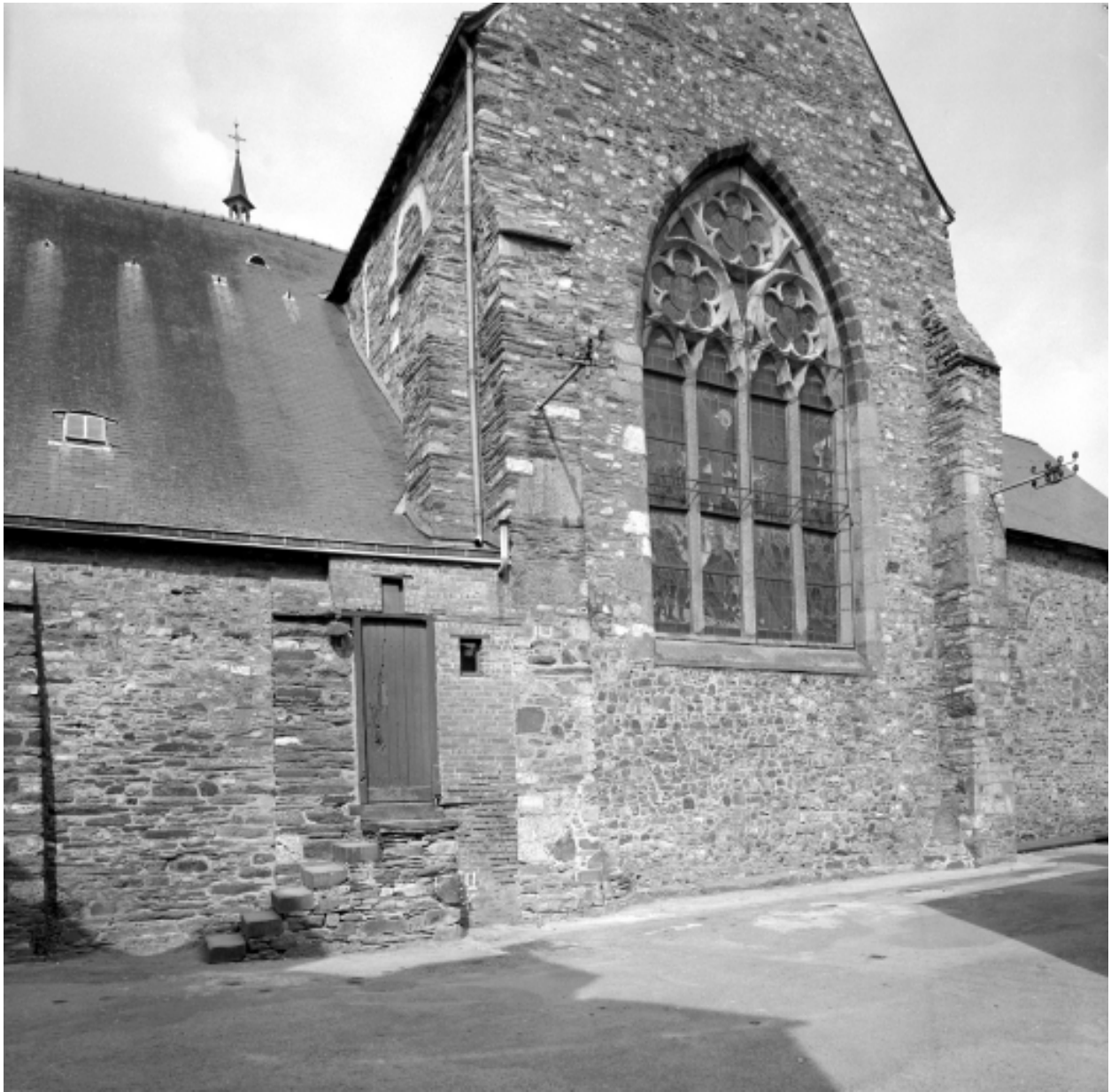
Elévation est, vue générale.
