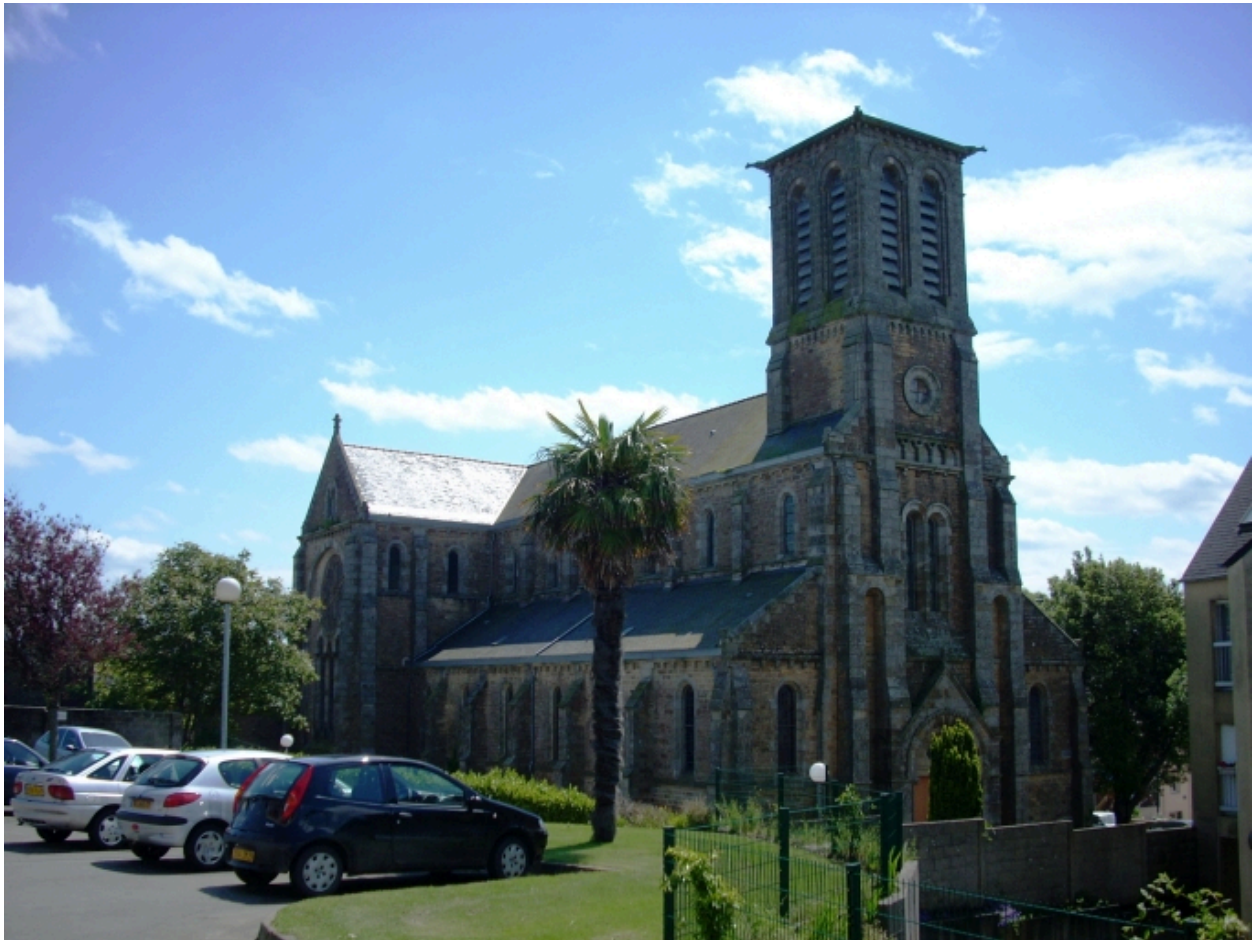
Le Relecq-Kerhuon, église Notre-Dame : vue générale nord-ouest
