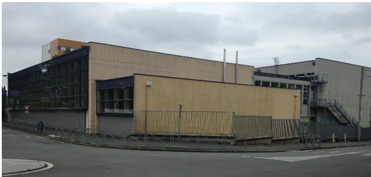
Gymnase vu du nord-ouest
