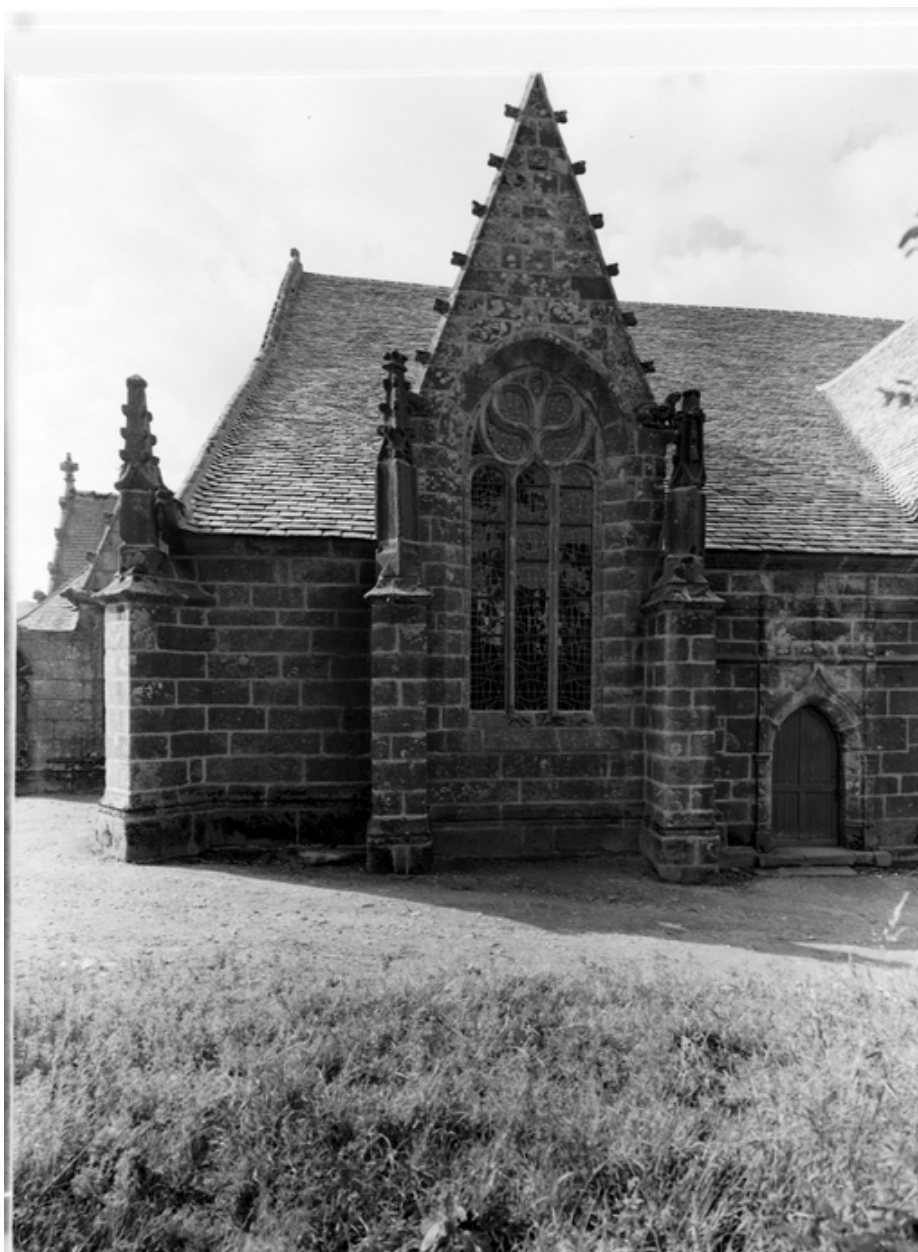
Face nord du bas-côté nord : gâble de la fenêtre est
