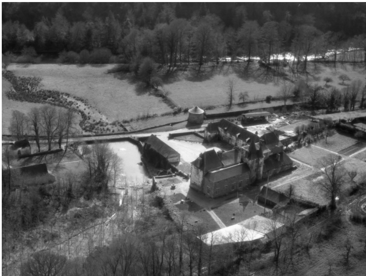
Vue aérienne : vue générale nord-est
