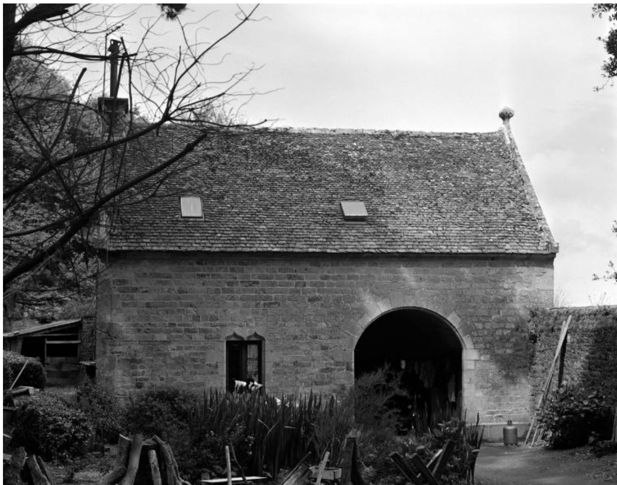
Maison de garde, élévation sud, vue générale
