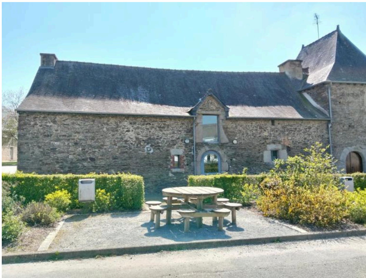
Façade nord, détail
