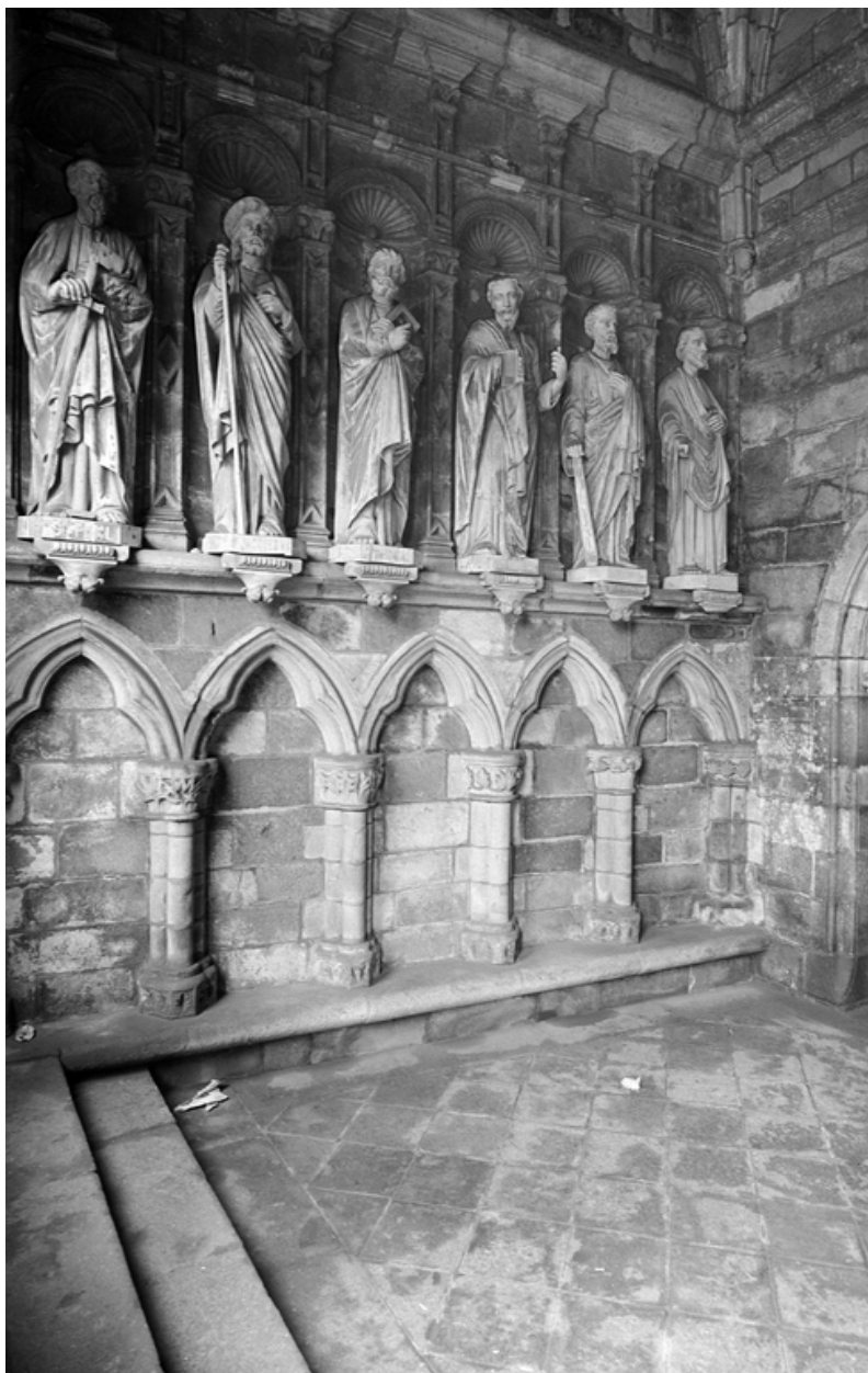
Porche sud, intérieur : vue générale des apôtres du mur ouest
