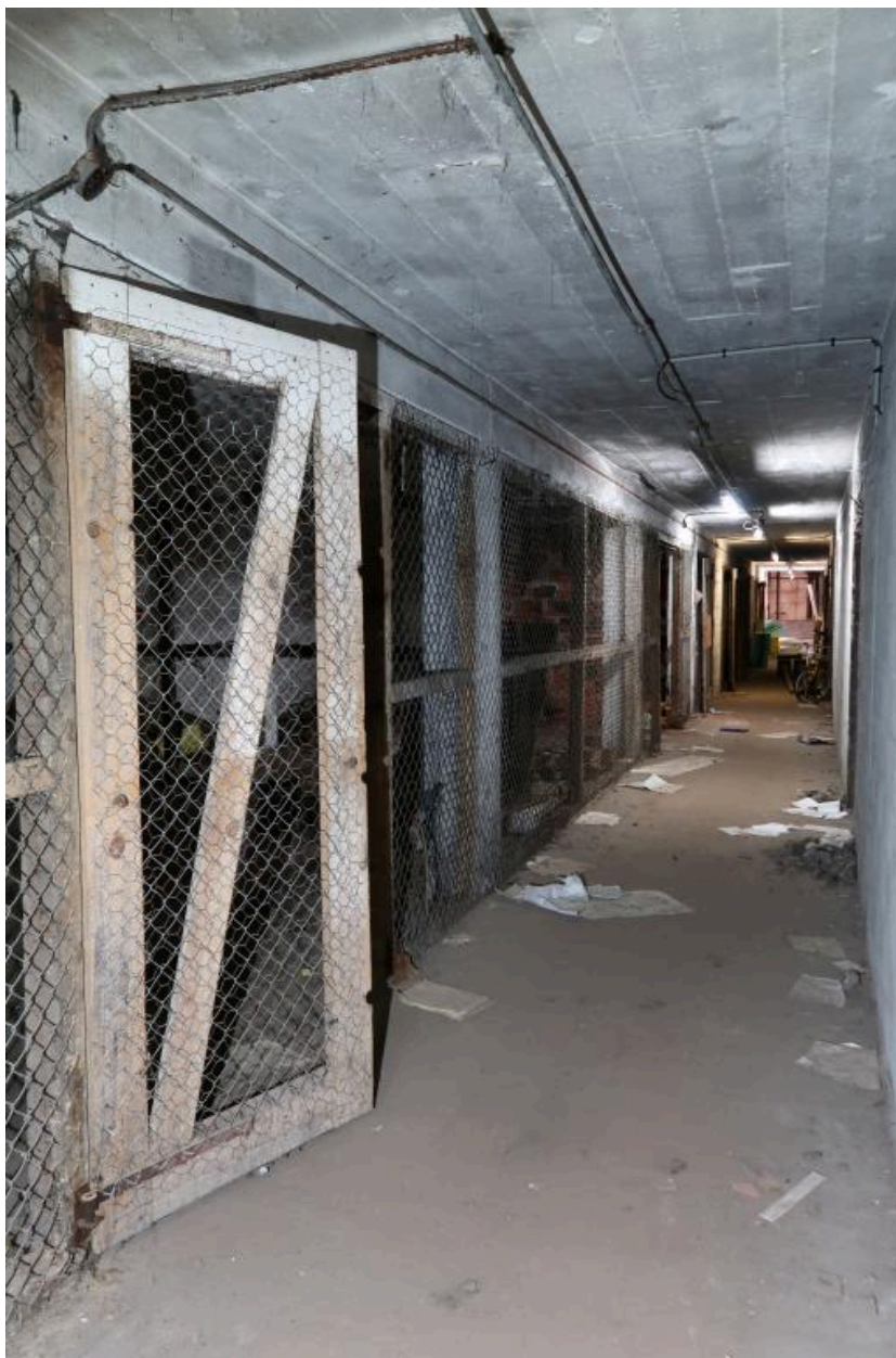
Premier étage : couloir central desservant les boxes
