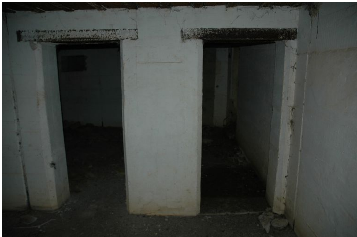
Vue intérieure de l'un des bunkers (état en 2008)
