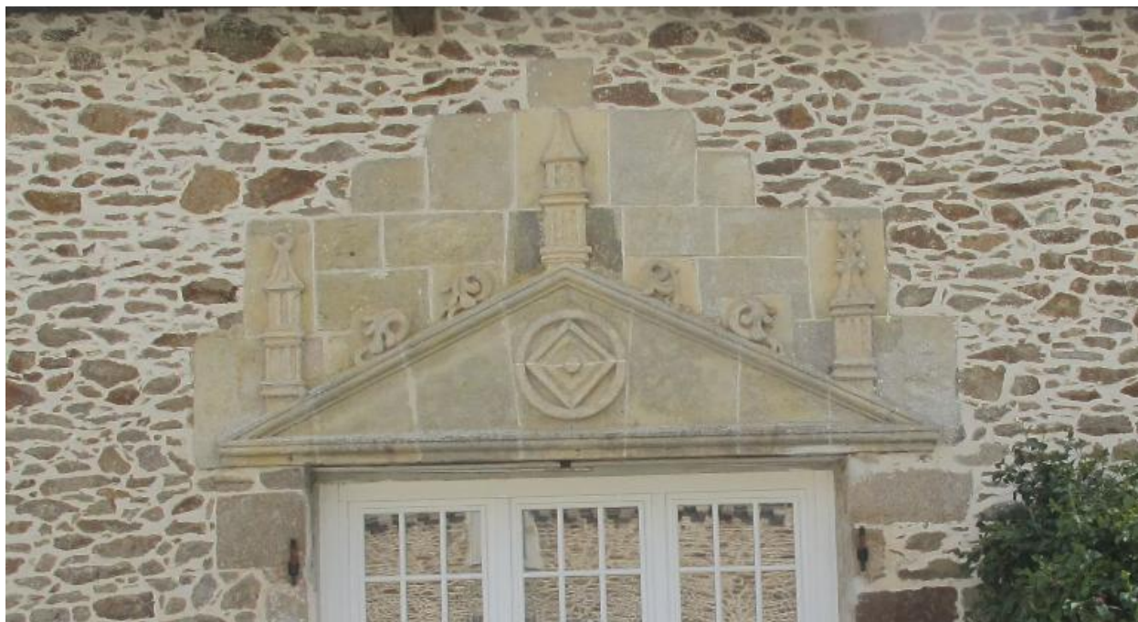
Communs, aile sud, détail du portail à fronton et candélabre
