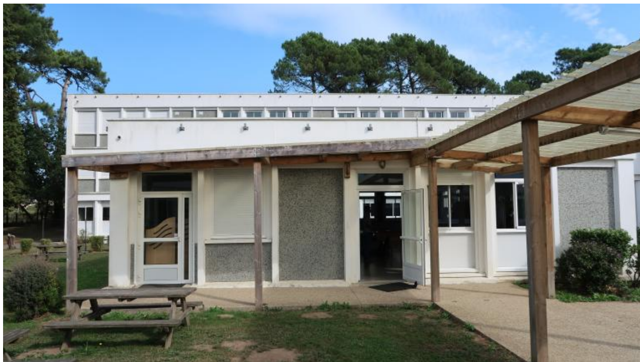
Foyer des élèves, façade ouest. Yves Guillou, architecte, 1969.
