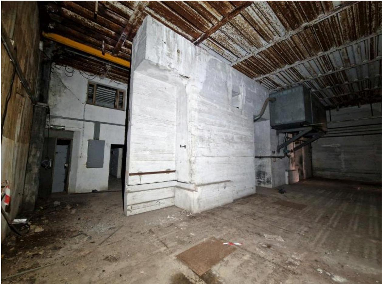
Locaux techniques, premier étage : mur de refend divisant les parties nord et sud. Sur le mur côté sud, grand réservoir métallique (caisse de réserve) fixé en hauteur. Le plafond est en tôle nervurée en acier
