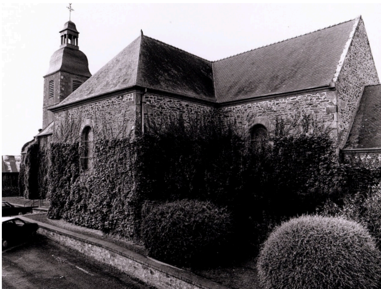
Vue générale sud-est
