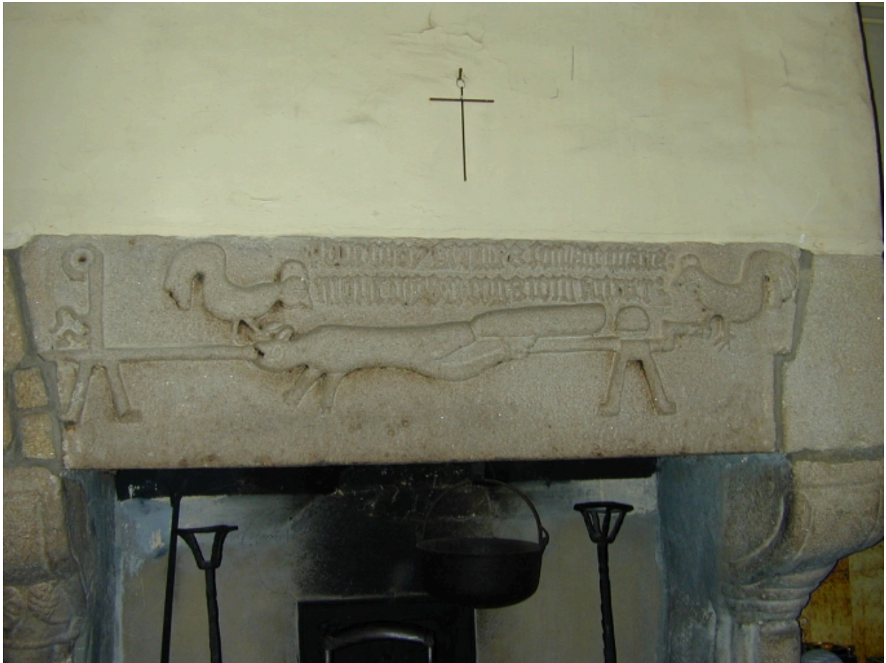
Logis, intérieur, cheminée de la cuisine : détail
