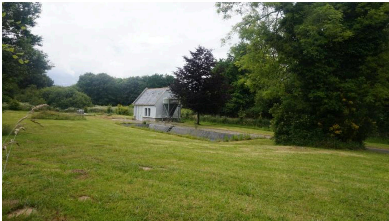
Vallon de Troménec : aménagements, station de pompage
