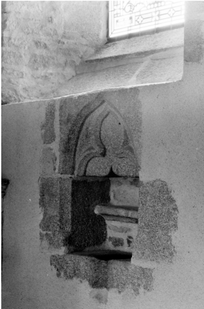
Intérieur, chœur, mur sud, niche : vue générale.
