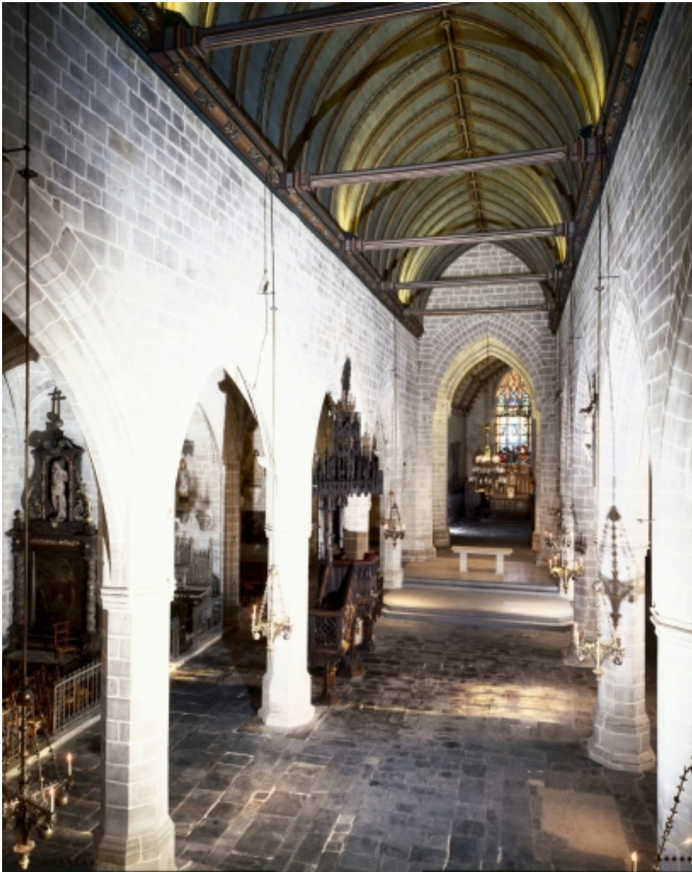
Vue d'un collatéral.
