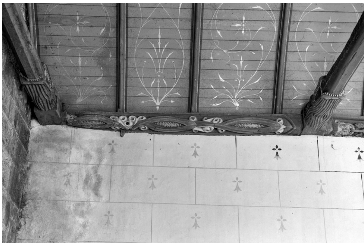
Nef, mur nord, sablière, d'ouest en est : 1er motif
