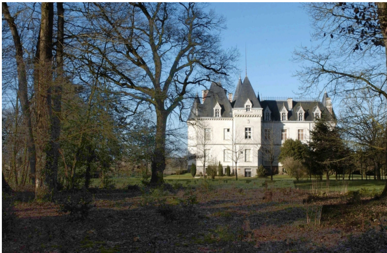
Vue générale nord
