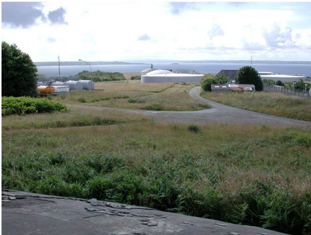
Vue générale du parc à carburant de Maison Blanche
