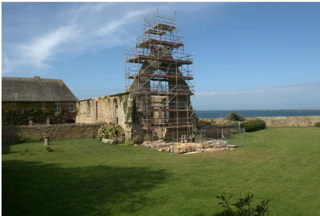
Vue du pignon est de la chapelle en restauration
