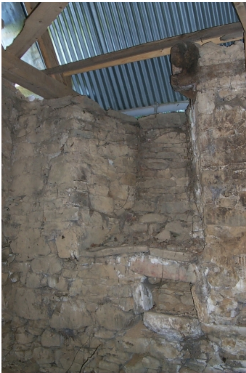
Intérieur, mur sud, baie éclairant le chœur
