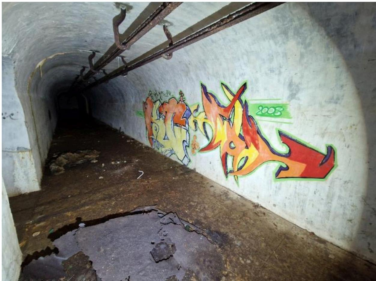
Vue intérieure du magasin à munitions : fixations et rail pour la manutention des obus via un palan. Ce grafitti est daté de 2008
