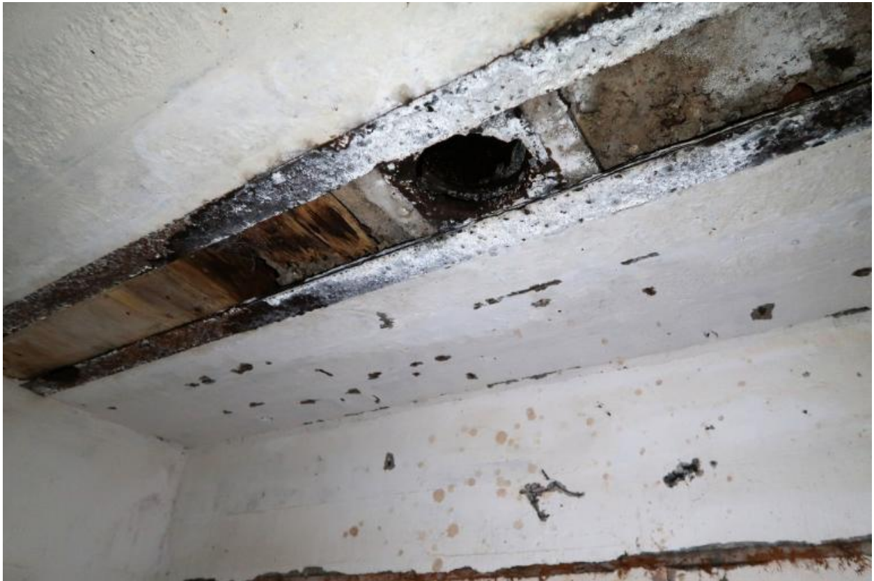
Vue intérieure : détail du plafond de la salle de garde est, puits pour un périscopes ?
