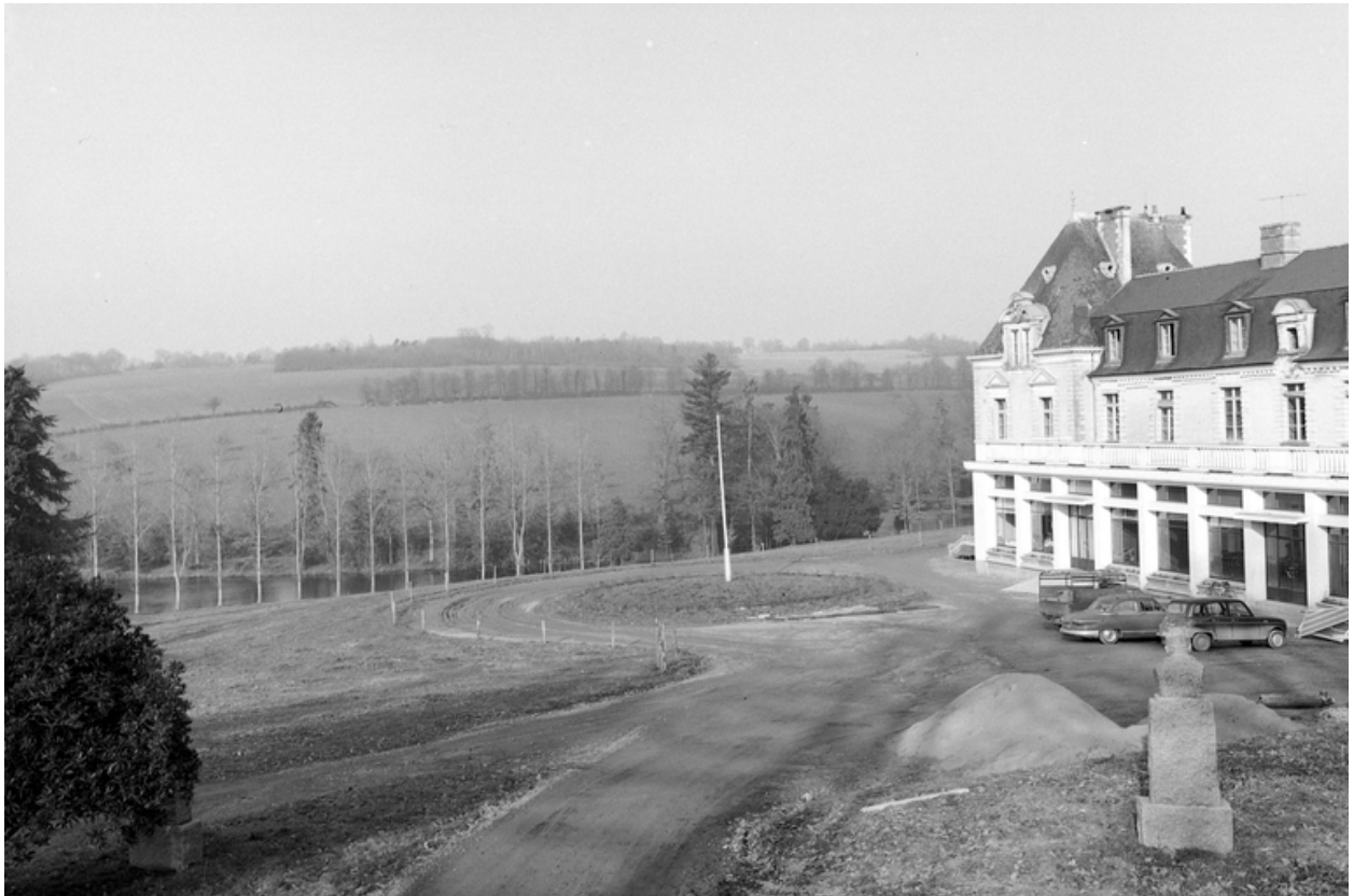
Vue prise du sud ouest.
