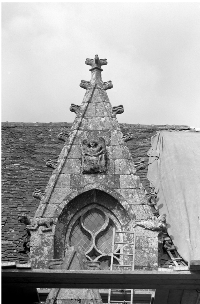
Façade sud : détail de la fenêtre au-dessus du baptistère
