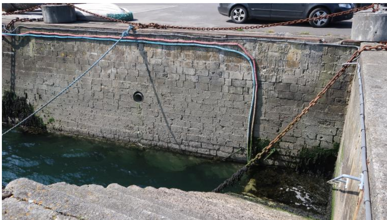
Quai des Baliseurs, escaliers et maçonnerie
