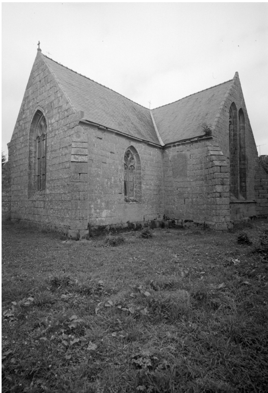
Façades sud et est : angle du chevet et du croisillon sud
