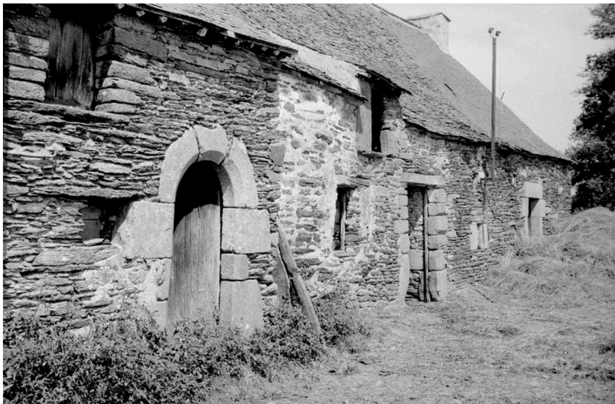
Le Coudray : ferme 3 vue du sud (état en 1969)
