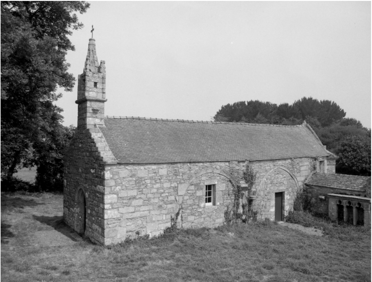
Saint-Vougay, chapelle Saint-Jean-Baptiste : vue générale sud-ouest, état en 1983
