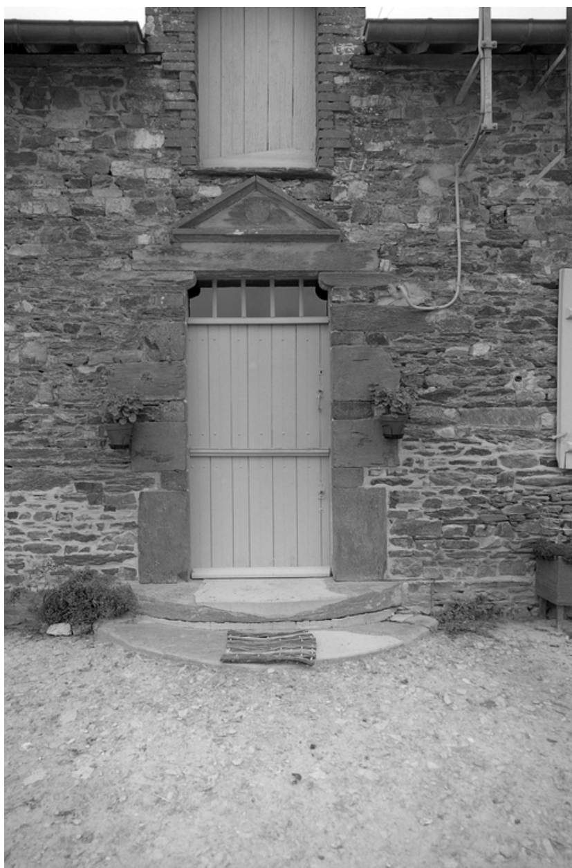
Logis, façade sud, vue de détail de la porte.
