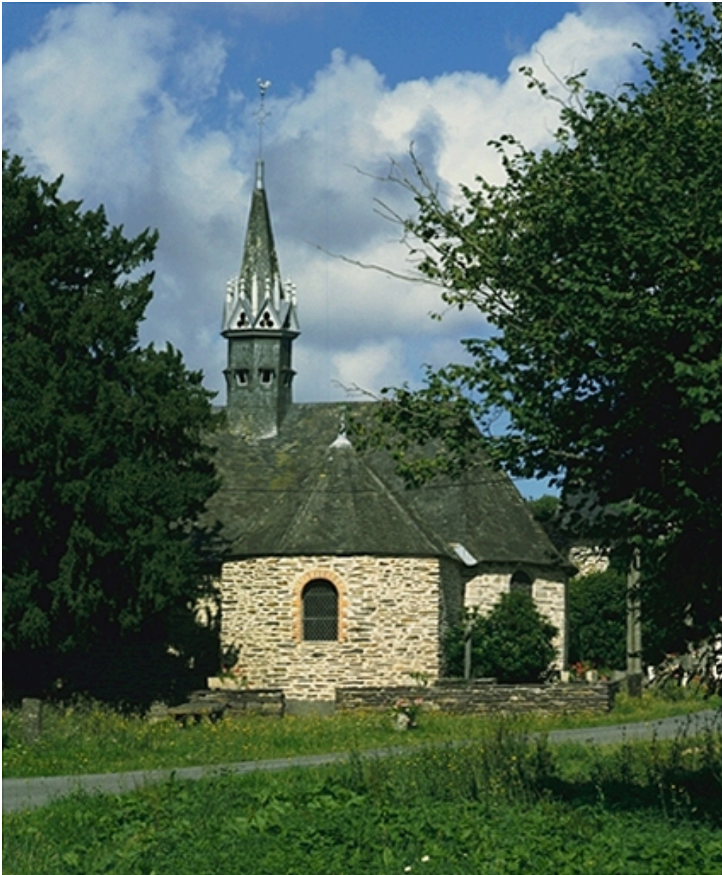
Vue générale sud
